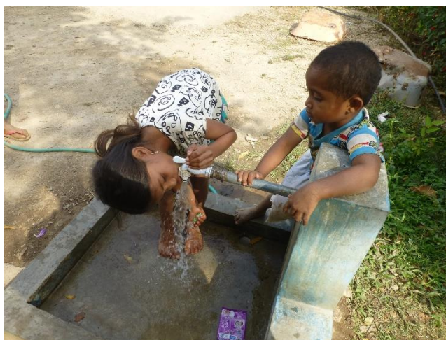
社会開発資金を使用して建設した水道施設
